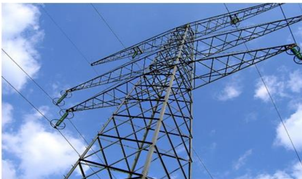
Figure 1.8 : Pylône en acier d'une ligne à haute tension [30]
