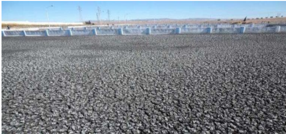
Figure n 13 : lit de séchage.
