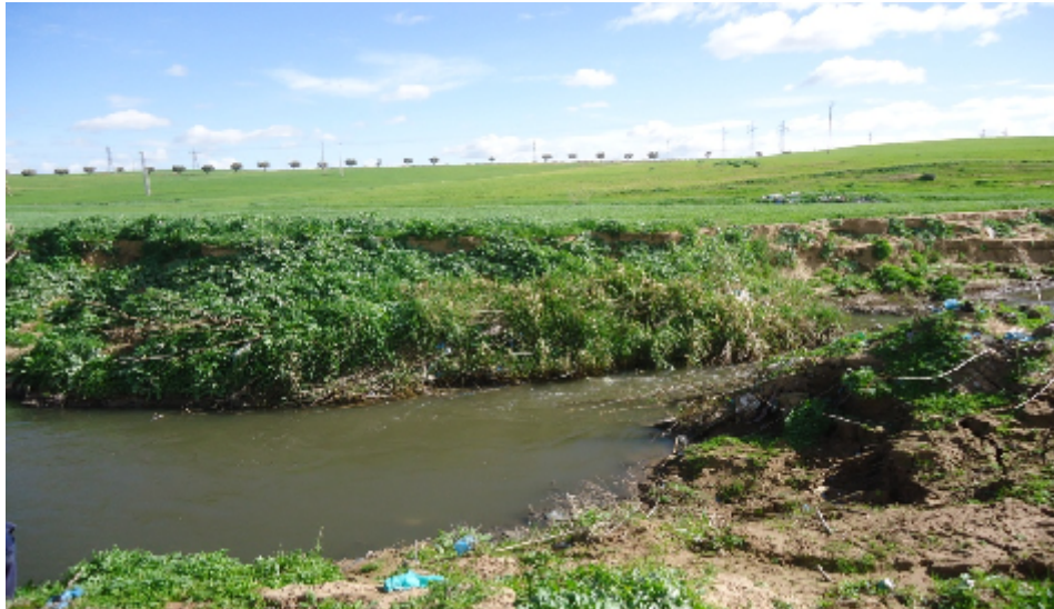
Photo n° 2 : Eaux industrielles véhiculées par l’oued Mekerra qui ne sont pas pris en charge par la STEP (Cliché, Zouita, 11/03/2013).
