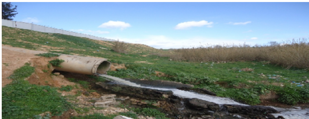
Photo n° 4 : Le prélèvement P1 à la sortie de la station d'épuration (11 mars 2013).
