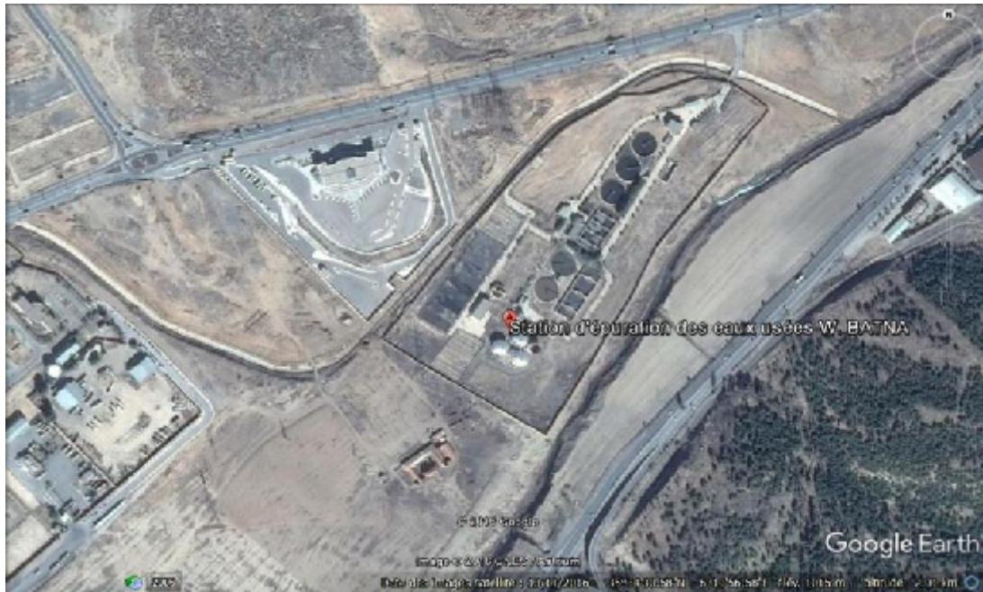
Figure n° 47 : Station d'épuration de Batna (Google Earth, 2017).
