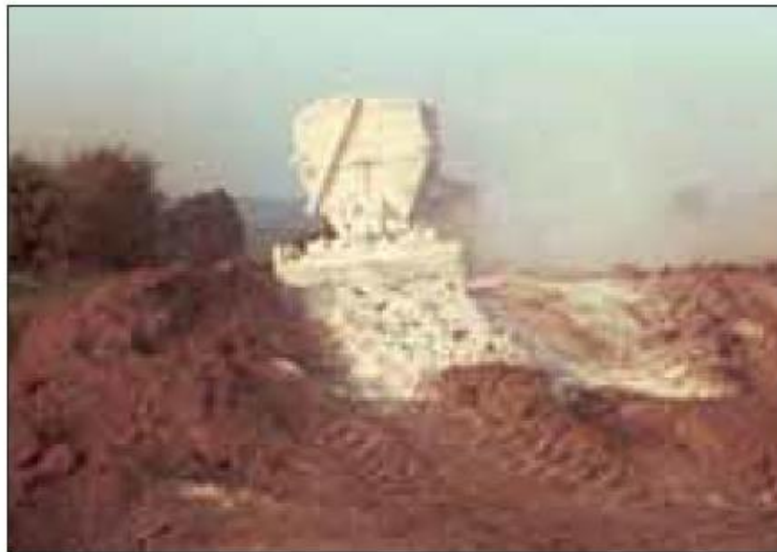
Photo VI.2. Epannage de l'agent de traitement.
