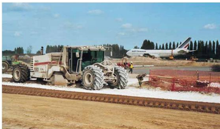
Photo VI.6. Le malaxage de liant au cours du traitement.
