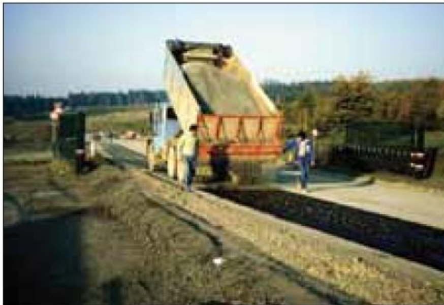
Photo VI.8. Exemple de protection des sols traités.
