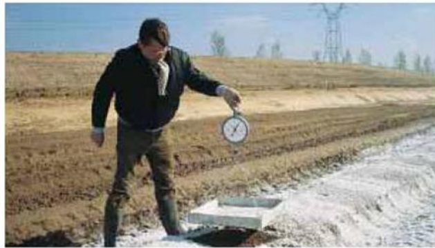
Photo VI.5. L'épandage et contrôle du liant.
