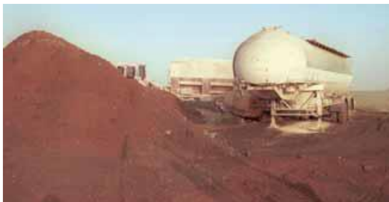
Photo VI.1. Silo horizontal semi-mobile [Code de bonne pratique pour le traitement].
