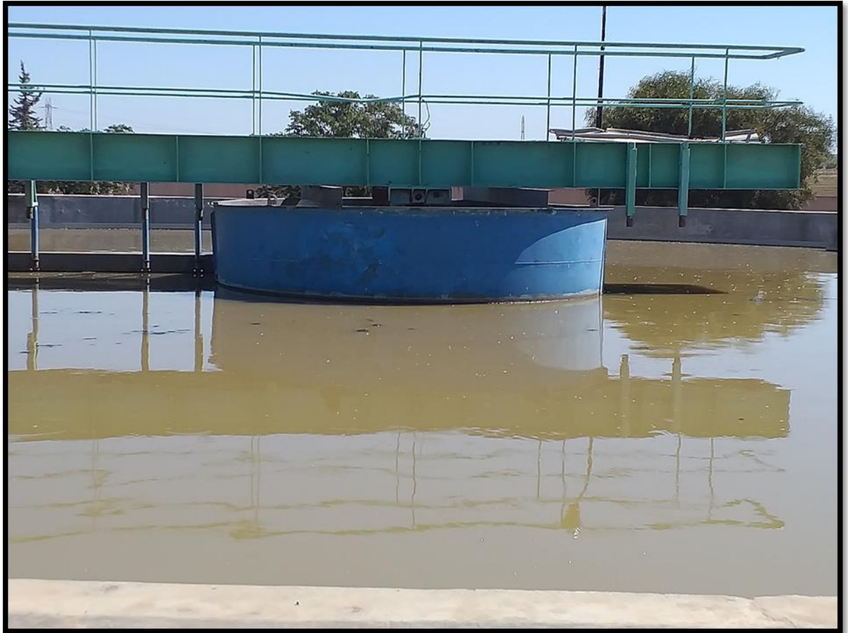
Figure n° 11 : Vue latérale du racleur de surface (ONA, SBA, 2021).
