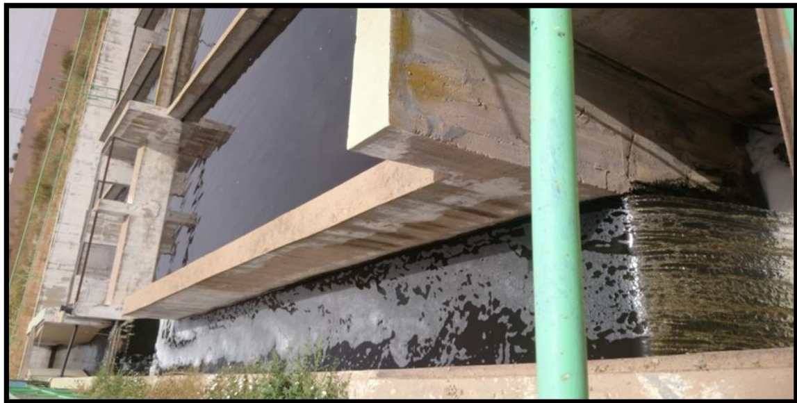
Figure n° 17 : La sortie des eaux épurées de la STEP vers l'Oued Makerra (ONA, SBA, 2021).
