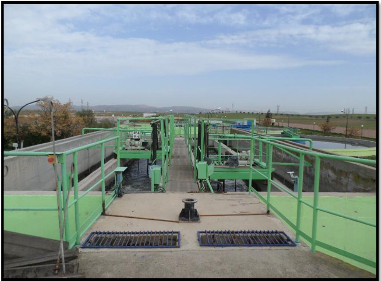
Figure n° 10 : Bassin de dessablage en cours de vidange (ONA, SBA, 2021).
