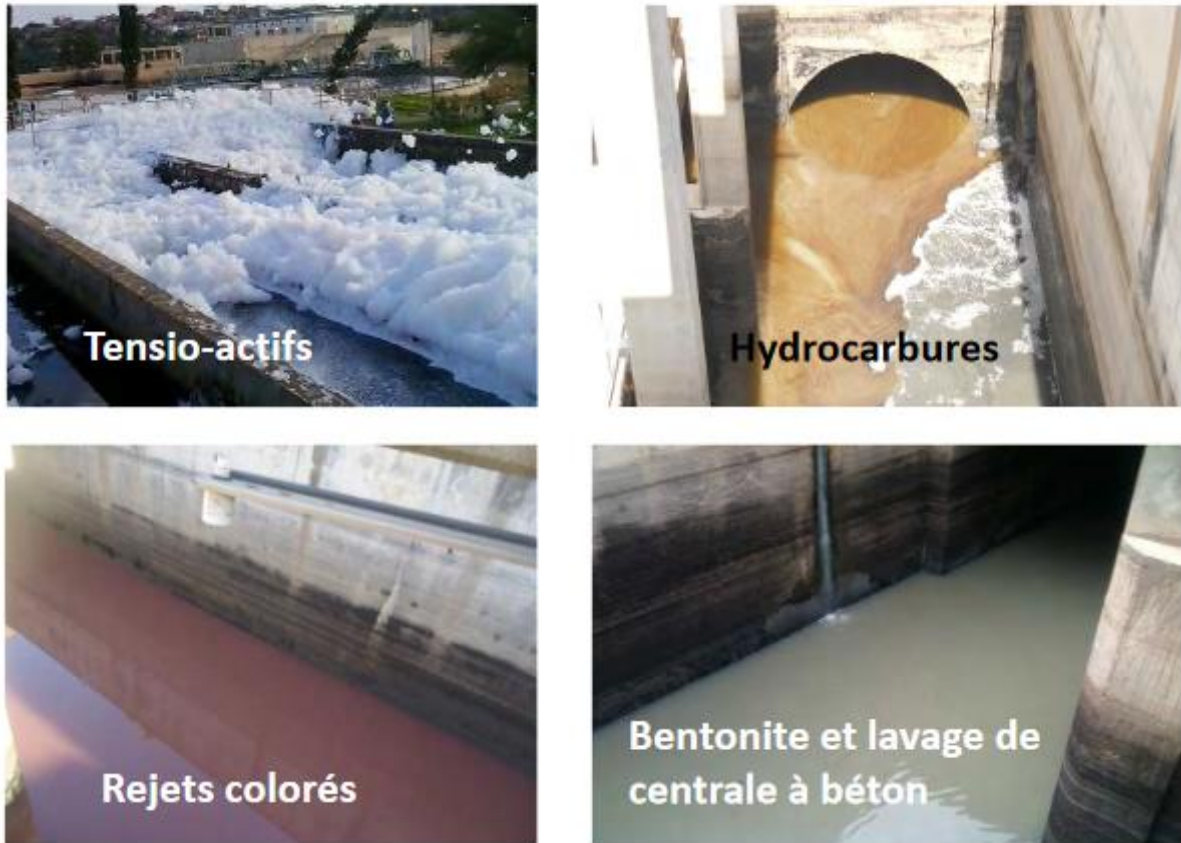
Figure 3. Quelques illustrations sur le rejet d'eaux usées industrielles en Algérie dans le réseau domestique 5
