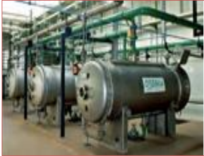
Figure 1.28 Traitement des eaux potables par l'ozone [6]
