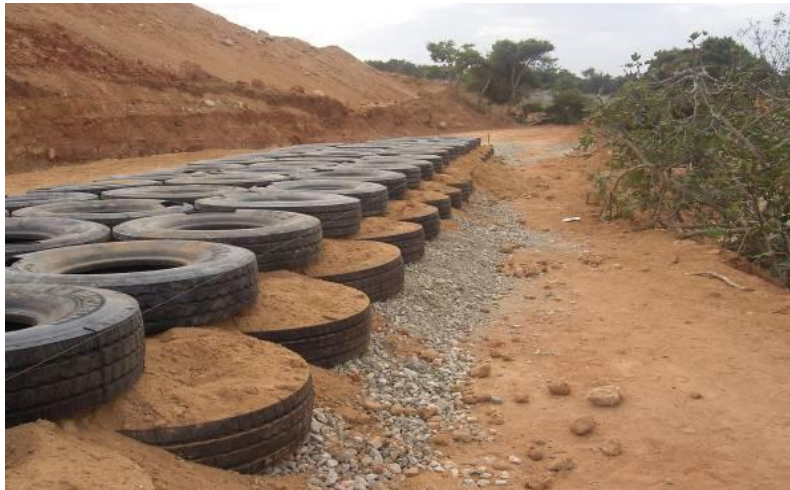
Figure 1.7 Pose des nappes de pneus projet pilote route de Bousmail ( www.mtp.gov.dz ).
