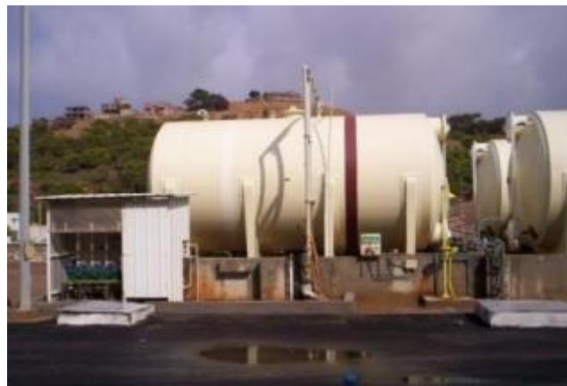
Figure 15 : photo d'une citerne de stockage d'hypochlorite de sodium (Benallouda, 2013)
