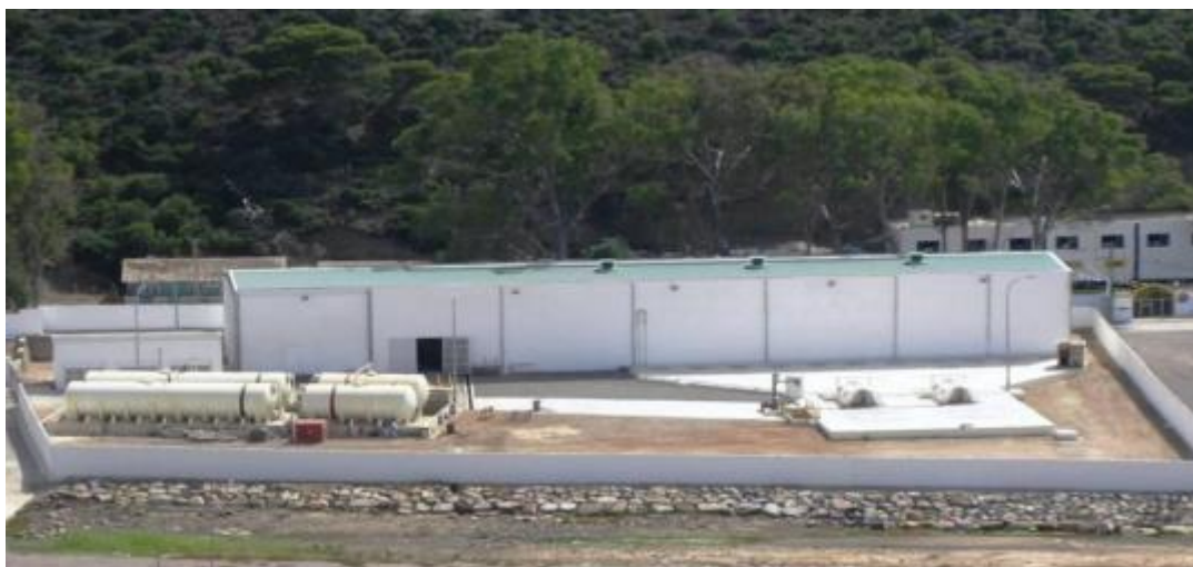
Figure 14 : photo du poste de pompage de l'eau de mer
