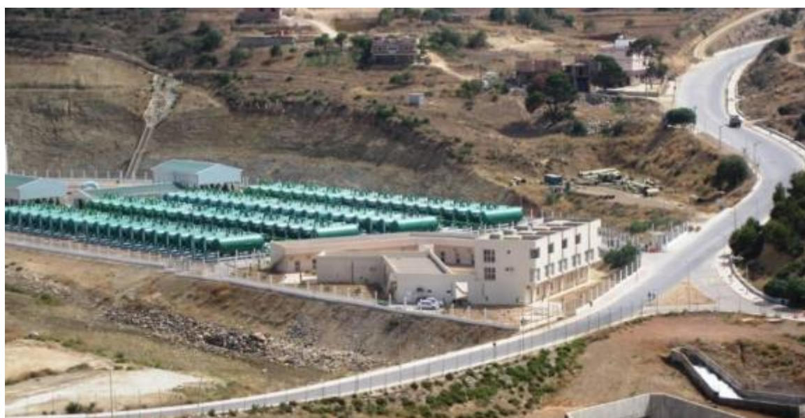
Figure 12 : photo de la station de dessalement de Honaine
