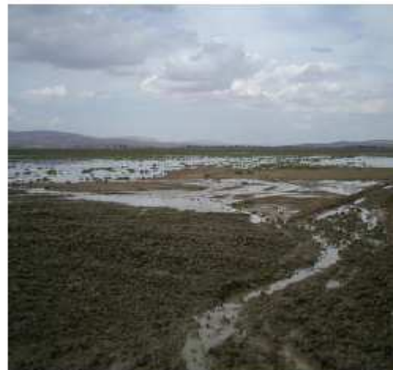
Photos III.4: Entraînement de la vase déposée en aval du barrage
