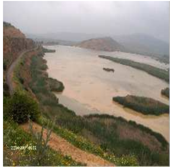
Photos II.2 : Envasement à l'amont du barrage (oued El Hamam) à environ 500m
