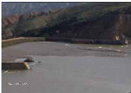
Photos III.1 : Envasement au pied du barrage
