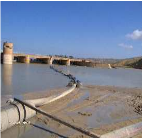
Photos II.1 : Envasement au niveau de la vidange du fond du barrage Fergoug
