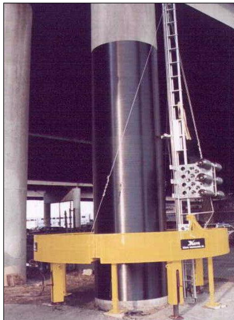
Fig. II. 10 : Colonne entièrement enveloppée par FRP (Enroulement filamentaire)
