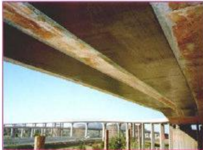
Fig. II. 5 : Renforcement par les FRP installés le long des poutres d'un pont
