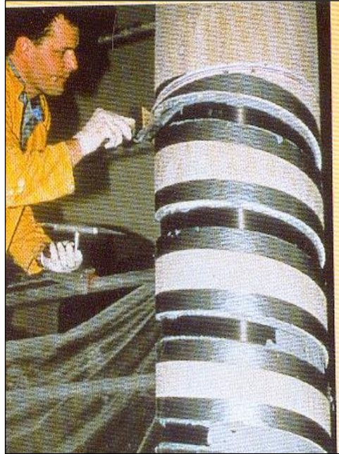
Fig. II. 9 : Colonne partiellement enveloppée par des bandes FRP.
