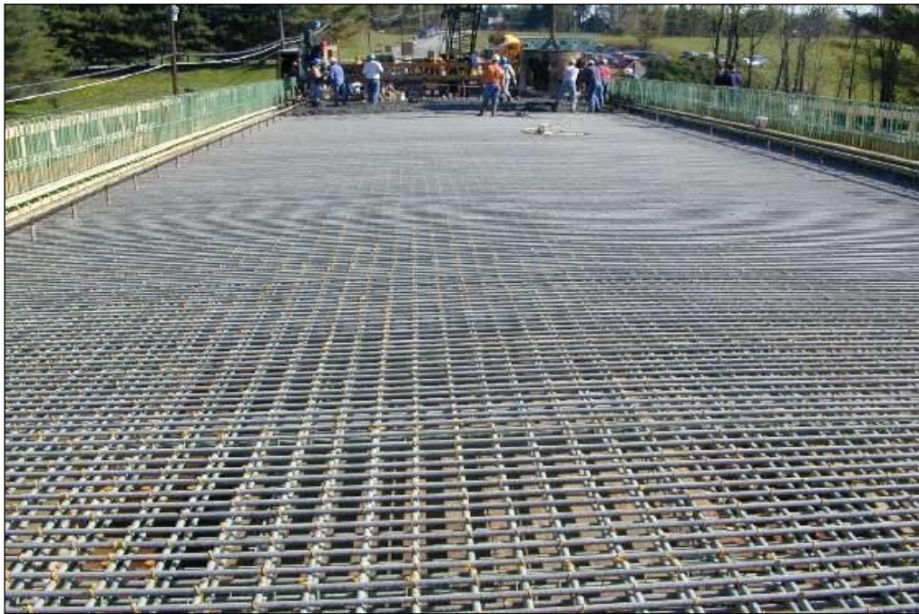
Fig. II. 11 : Barres d'armatures en FRP de verre placée dans un tablier de pont en béton avant le coulage du béton -Calgaro et Lacroix (1997).
