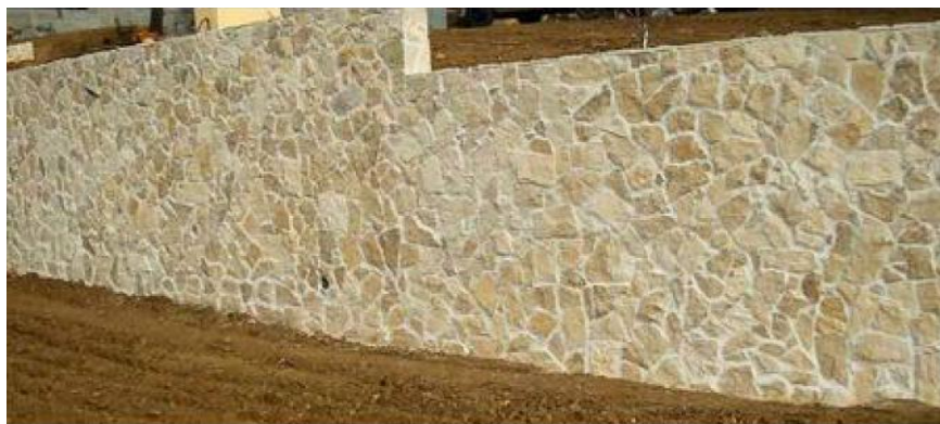
Figure I.7 : Mur en pierre naturelle
