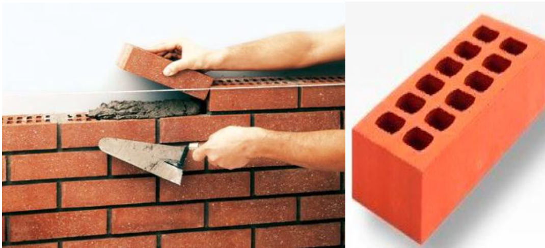
Figure I.12: Mur en briques perforées
