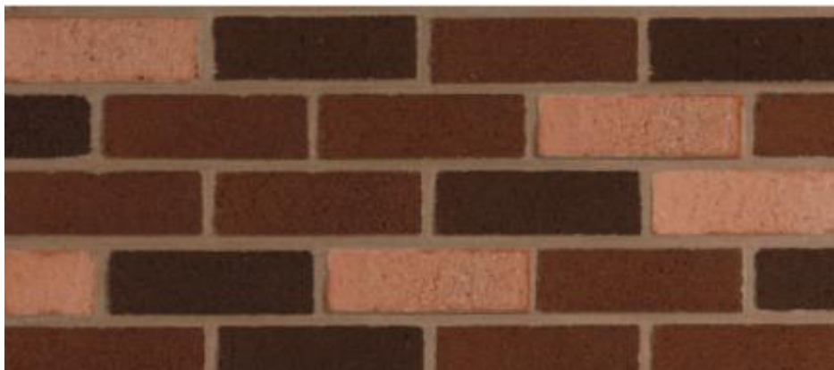
Figure I.15 : briques maintenus ensemble par un mortier.
