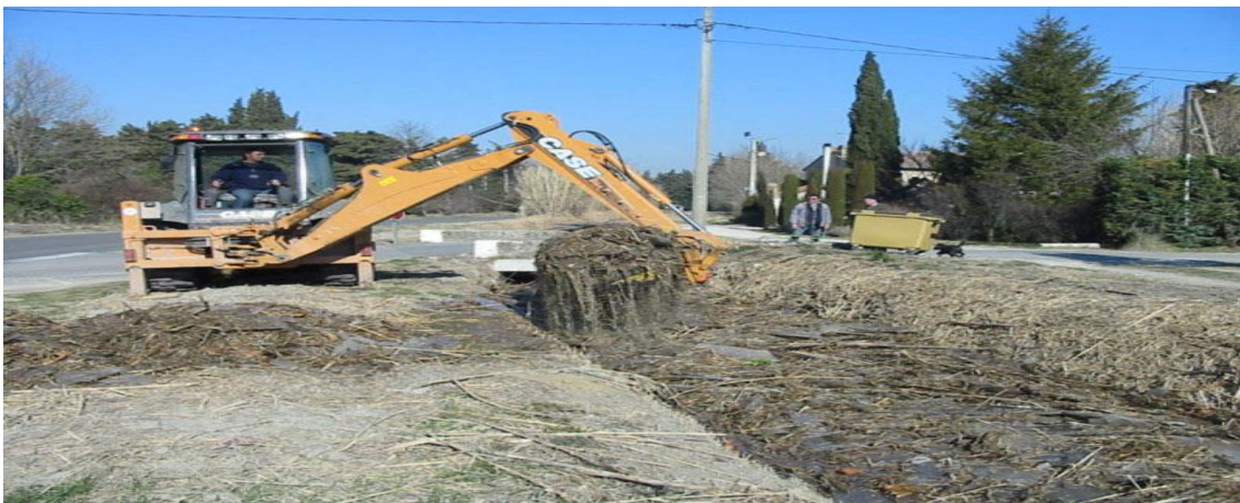
Figure 27 : Curage de canal (CANAL-ISLE.FR, 2019).
