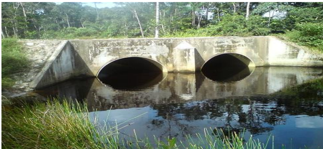
Figure 30 : Ouvrages de passage (GTI-GUYANE.FR, 2009).
