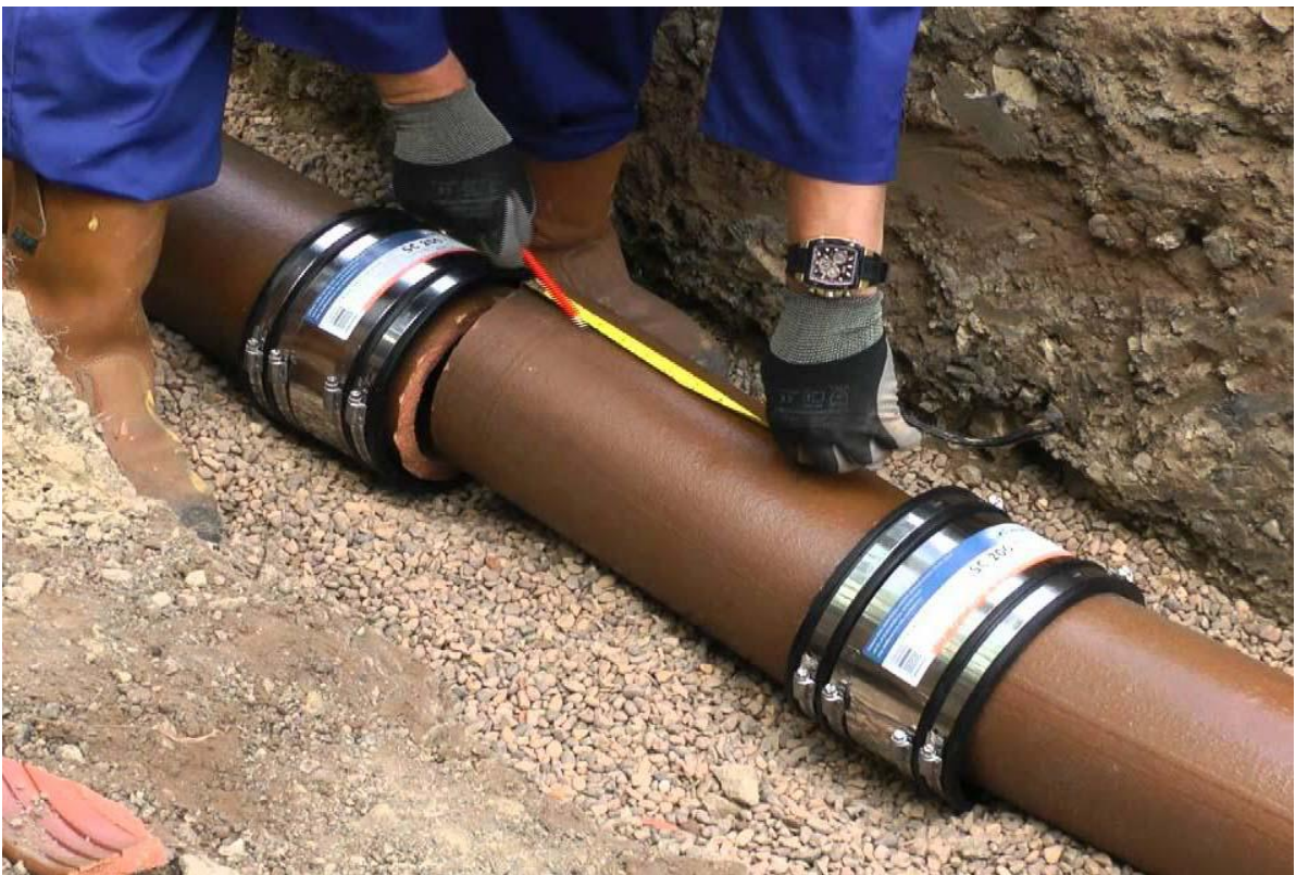
Figure 29 : Réparation de la conduite enterrée (PLOMBERIE EXPRESS, 2018).
