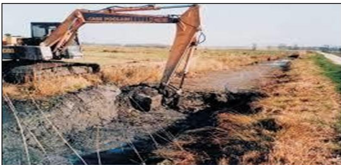
Figure 28 : Reprofilage des berges du canal. IN ( BEN SAHA et MESTOURI, 2020 )
