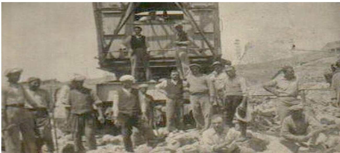
Figure .2 Équipe de chantier dans les Travaux de construction du barrage Bouhanifia (1930-1939), web 6
