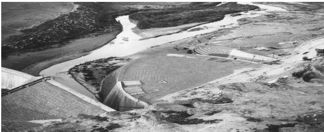
Barrage de Bou-Hanifia- Batardeau amont et les deux galeries séparées par un large môle 16/01/1939
