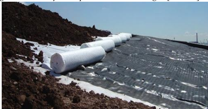
Figure1.7 : Géosynthétiques dans les décharges [CON20].
