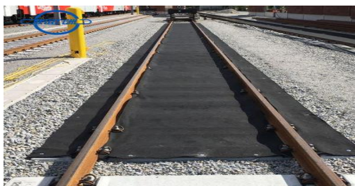
Figure 1.3: Géosynthétiques dans la route ferroviaire [MAD23]
