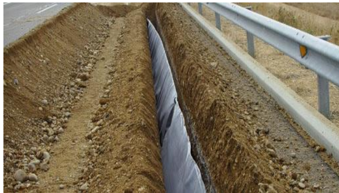
Figure1.4 : Géosynthétiques dans le système de drainage [CON20].
