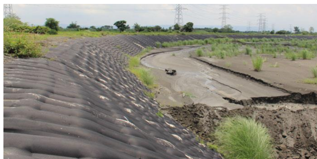
Figure 1.9 : Géosynthétiques dans le contrôle de l'érosion et des sédiments [CON20].
