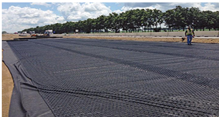
Figure 1.2 : Géosynthétiques dans les chaussées [CON20]
