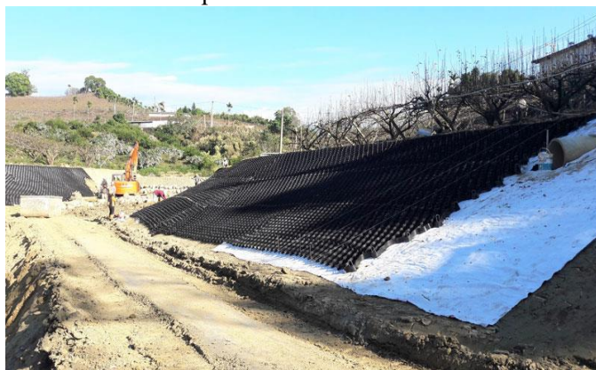
Figure1.6 : Géosynthétiques dans la stabilité des pentes [CON20]
