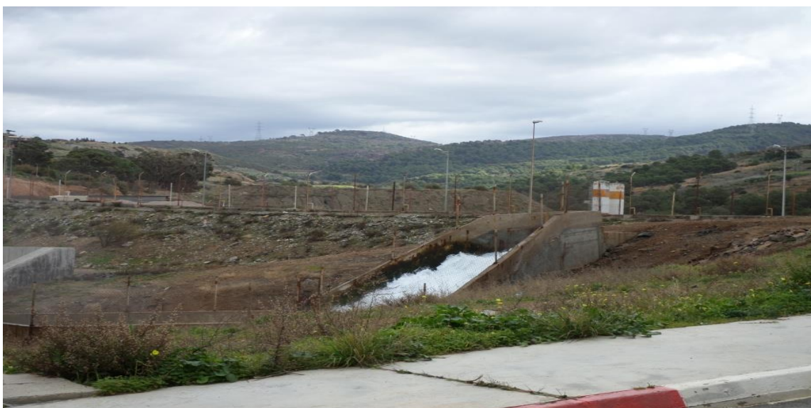
Figure (20) : Point de rejets de la station de Honaine.
