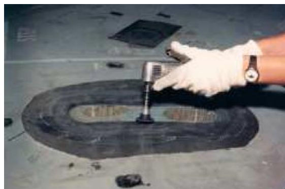
Figure II.17 : Préparation de surface pour collage des patches internes [66].
