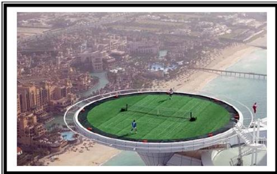
Ouvrages d'arts (plaques circulaire)
