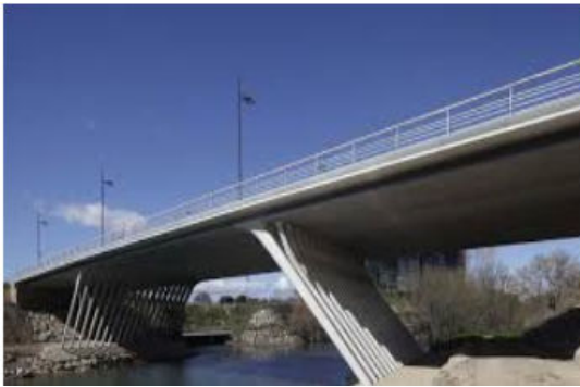
Ouvrages d'arts ponts
