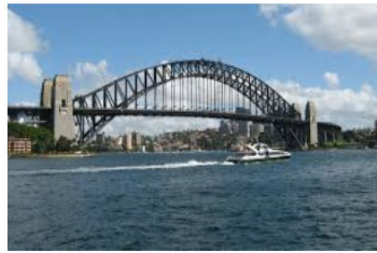
Ouvrages d'arts ponts (Tabliers)
