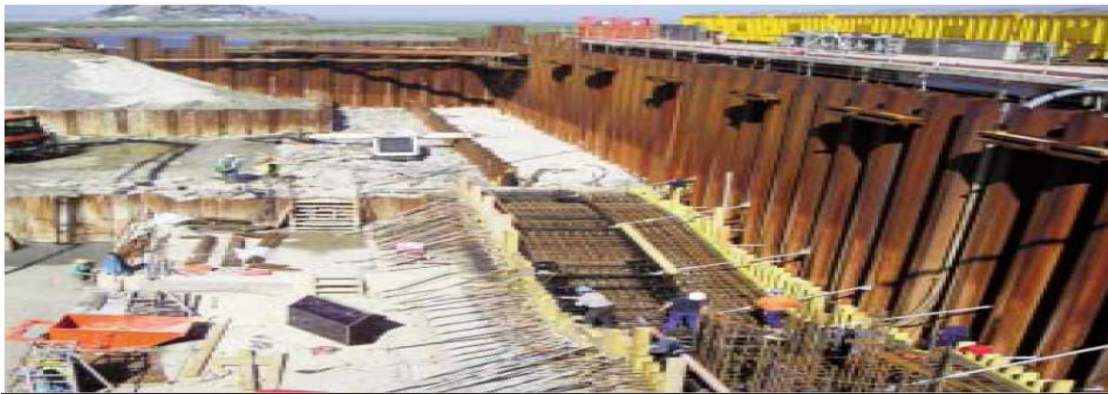
Figure1.26. Le grand barrage de Mont Saint Michel en France[MAR90].
