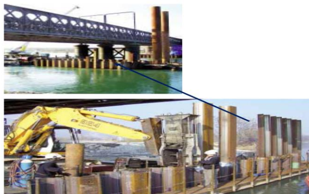
Figure1.27. Chantier d'une reconstruction d'un pont en utilisant des palplanches métalliques[MAR90].
