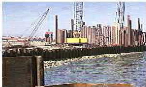
Figure1.23. Quai permettant l'accostage de superpétroliers[ALB07]
