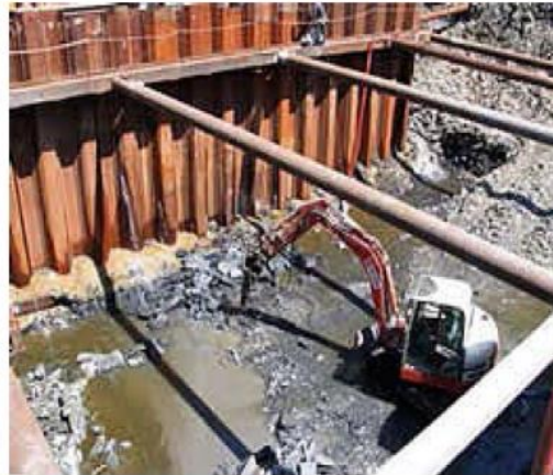
Figure1.25. Terrassement dans le batardeau[ALB07].
