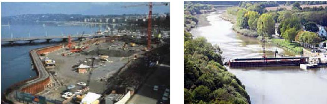
Figure1.24. L'utilisation des palplanches comme batardeaux en rivière en France [ALB07]
