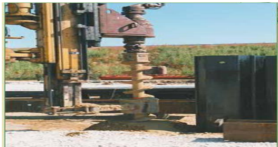
Figure1.30. Perforage avant fonçage
