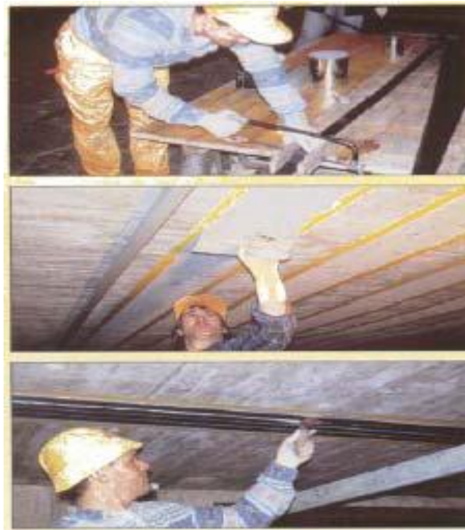
Figure II.4 : Procédé par collage de plaques d'après Sika Carbodur
