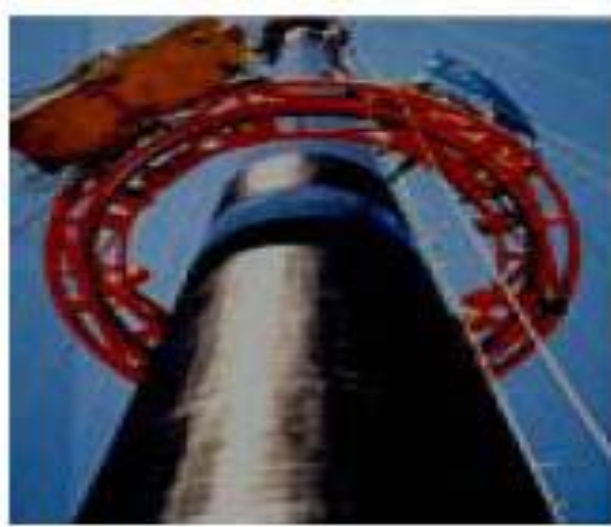
Figure II.5: Renforcement par fibres filamenteuses, enroulement automatisé
