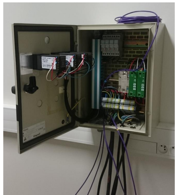
Figure IV.6. Unité de commande de la température
