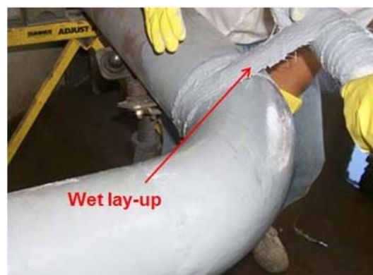
Figure II.9 : réparation des coudes par patch en composite [32].
