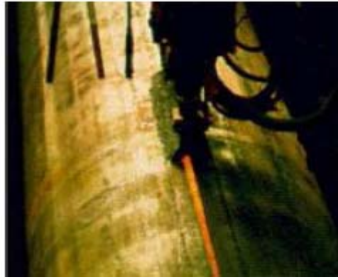
Figure II .5 : Soudage d'un pipeline [30].
