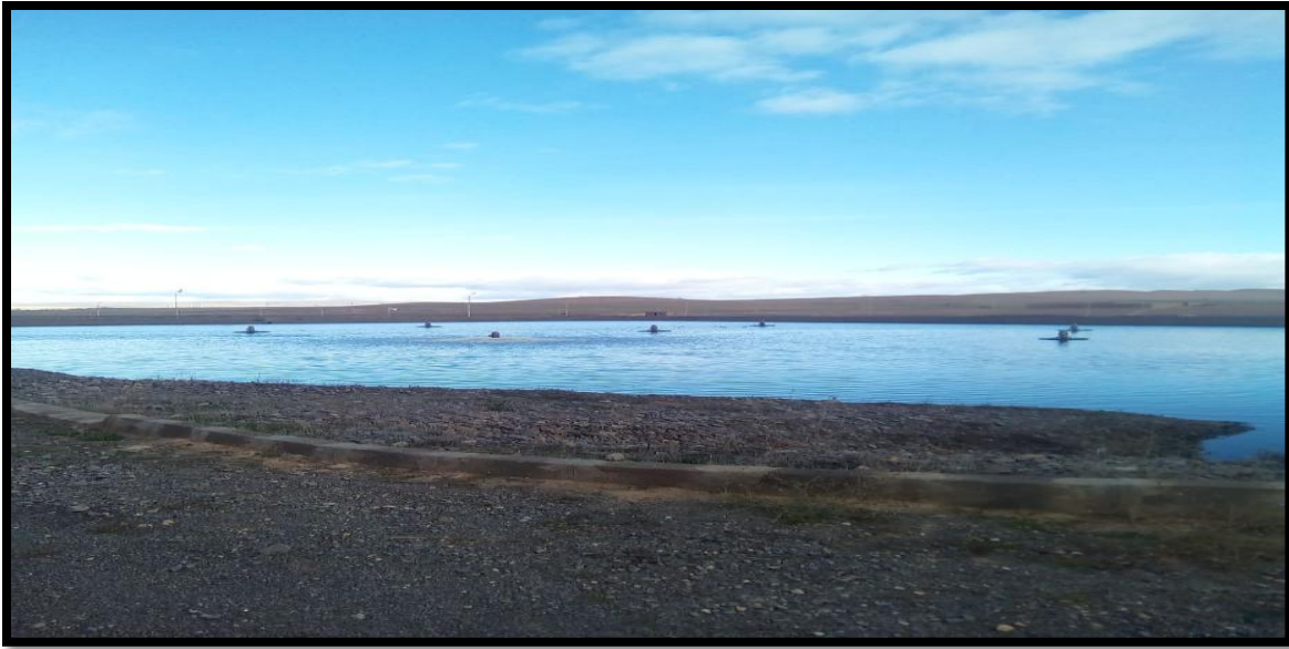
Figure n°51 : bassin d'aération N°02 (SOUMIA ,2020)
