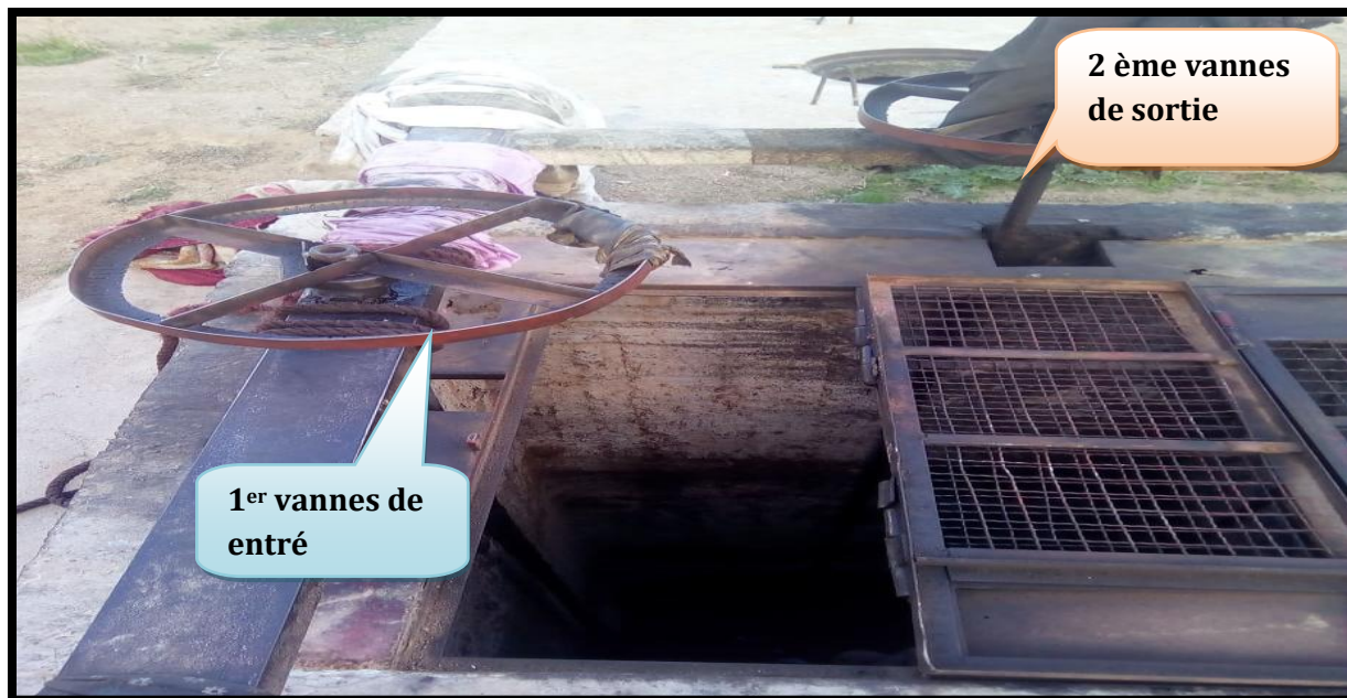
Figure n°46 : le by-pass (SOUMIA ,2020)
