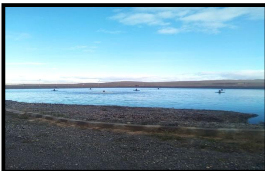
bassin d'aération N°02
