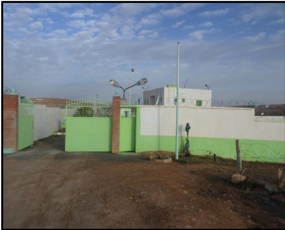
Figure n°42 : la STEP de Ras EL Ma (cliché personnel)
