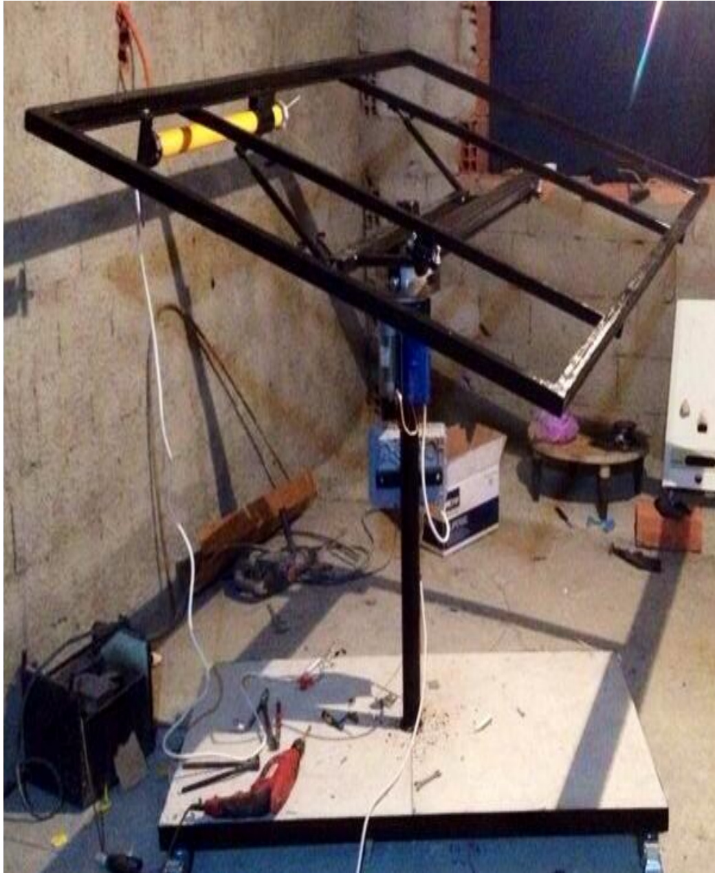
Figure 5. 17 : Structure métallique avec motorisation porteuse des panneaux PV
