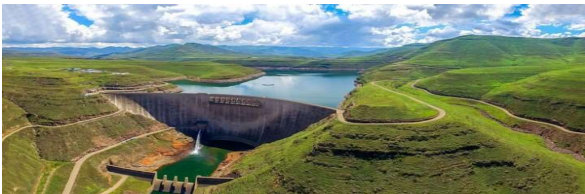
Figure I-3 Barrage de Katse-Lesotho Afrique de Sud
