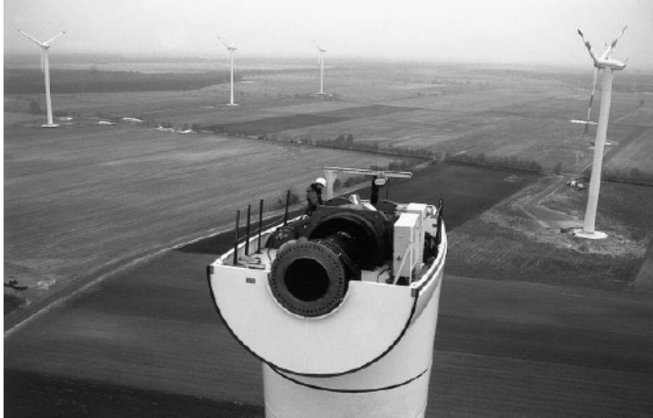
Figure I.20 : Vu aérienne de la nacelle pendant l'assemblage d'une turbine.
