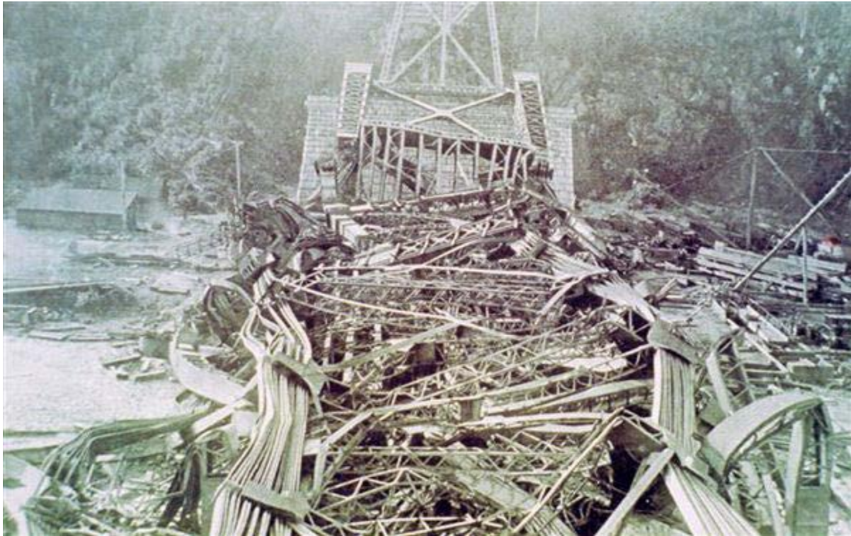
Photo III.2. L'effondrement du pont de Québec 1907
