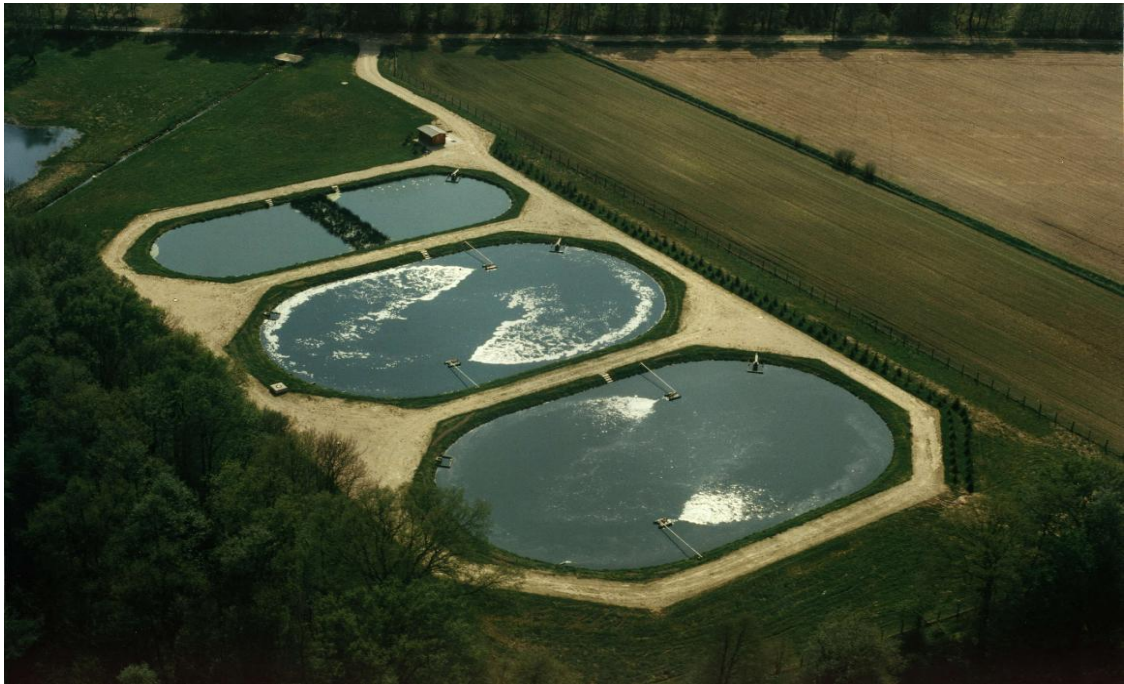
Figure 17 : image montrant la vue de dessus de lagunage aéré Source : (Site10)
