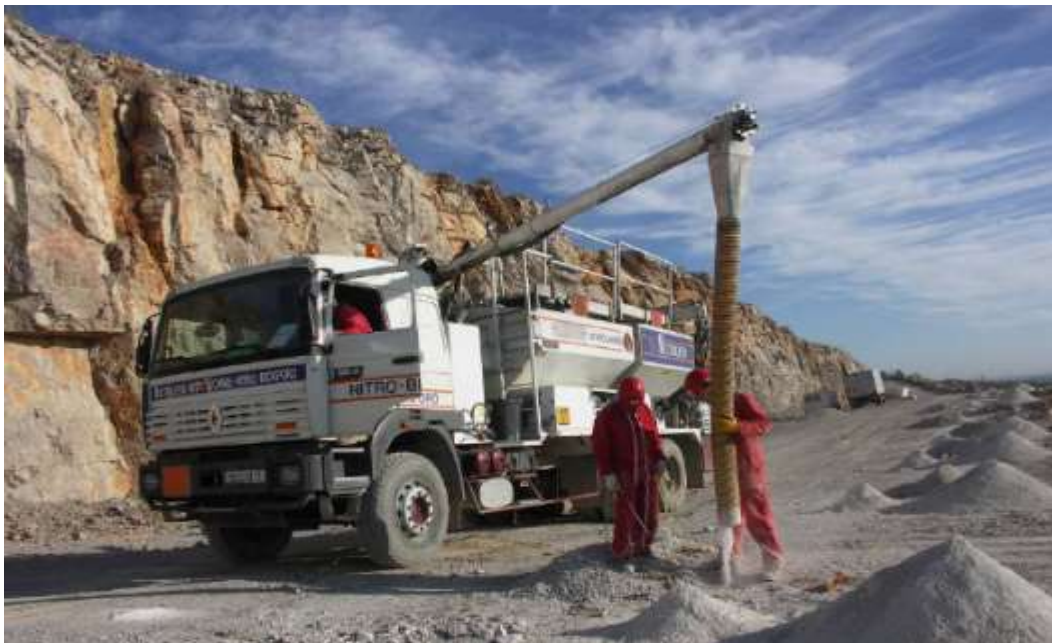
Figure 7: unité mobile de fabrication d'explosif (Poulard et al., 2017)
