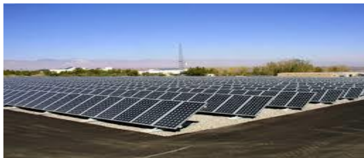
Figure I.19. Réalisation d'un champ photovoltaïque
