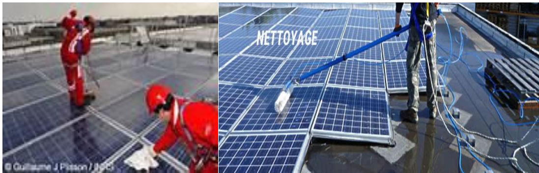
Figure I.18. Nettoyage des panneaux photovoltaïques
