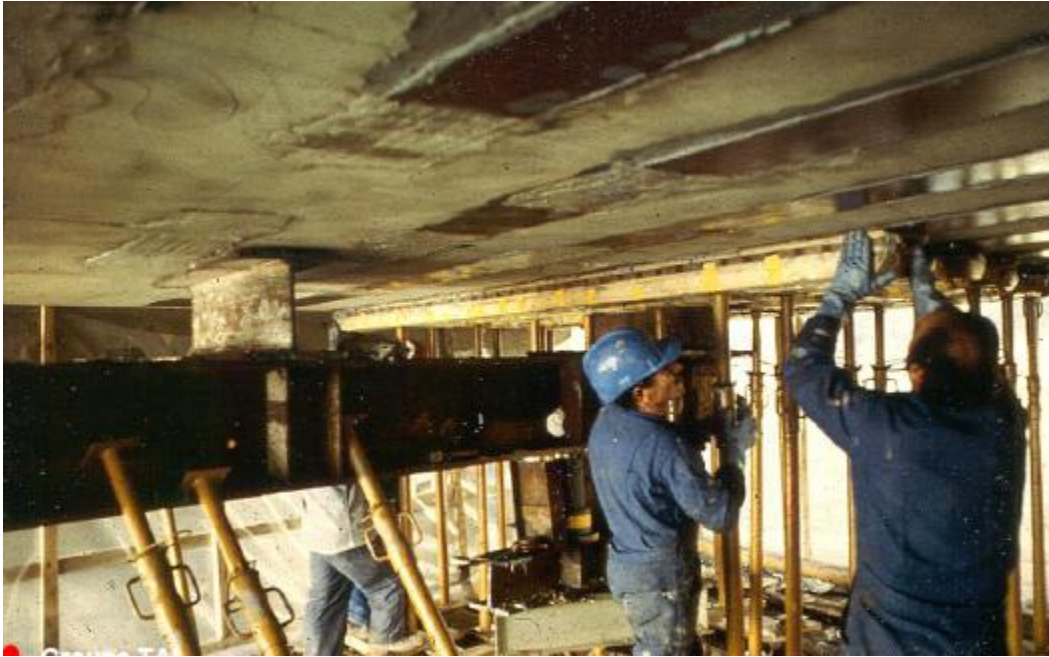
Figure II.9 : Renforcement par collage de plats métalliques
