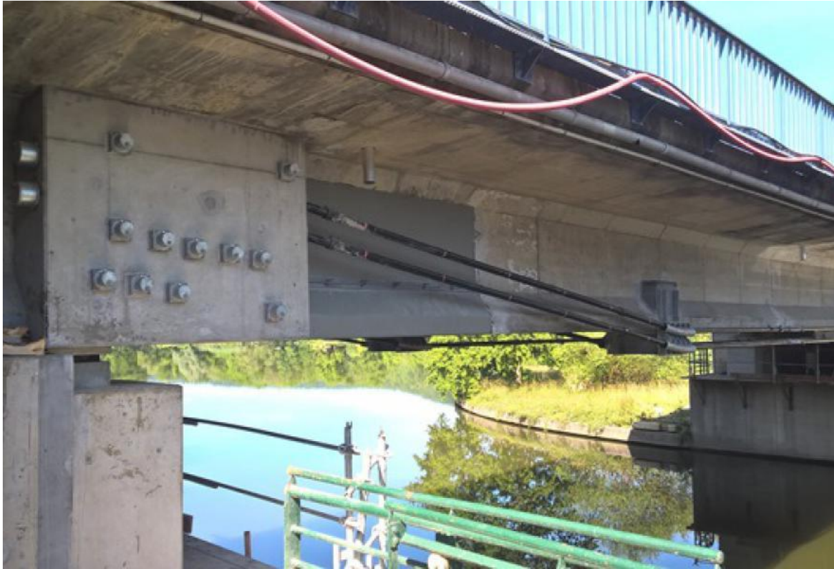
Figure II.8 : Réparation par précontrainte additionnelle
