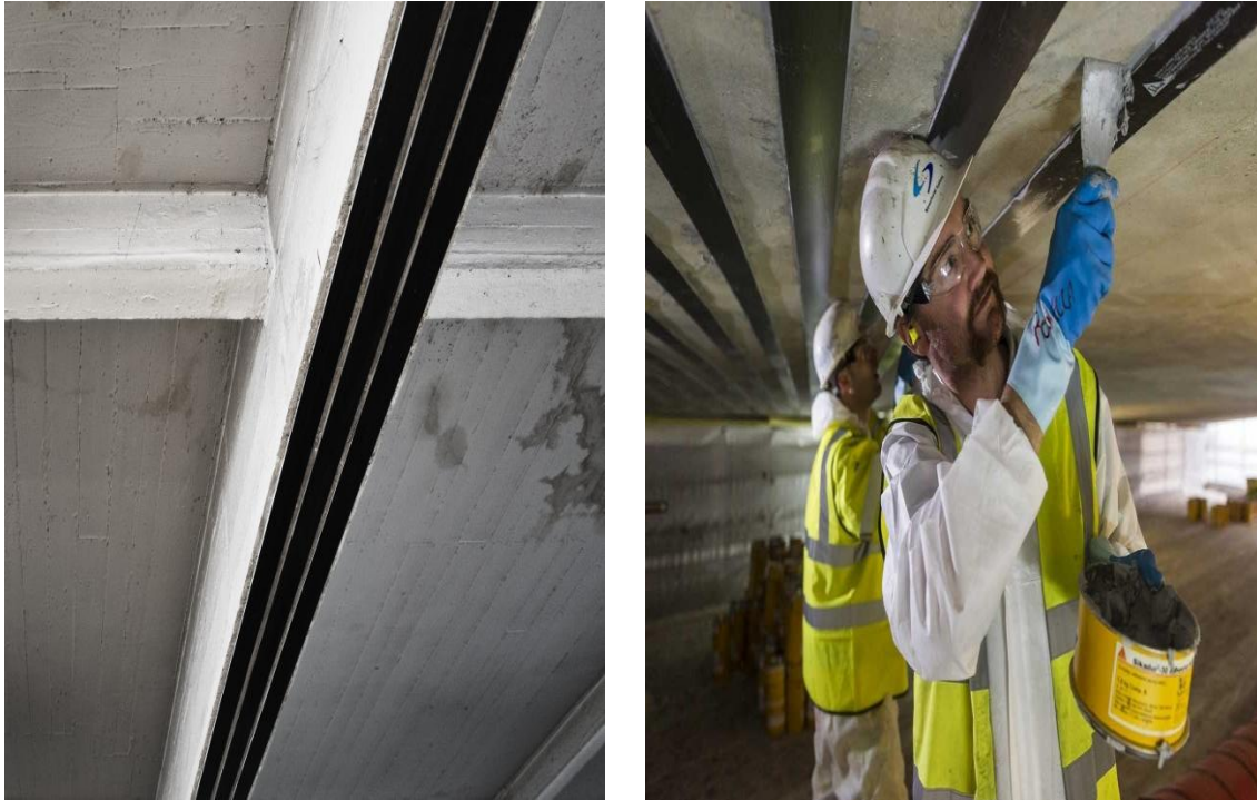
Figure II.10 : Renforcement par collage de plats composites
