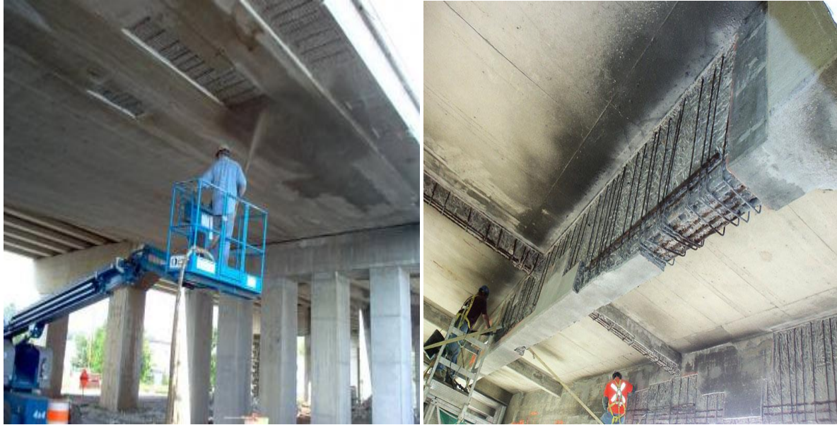
Figure II.7 : Réparation des ponts par béton projeté
