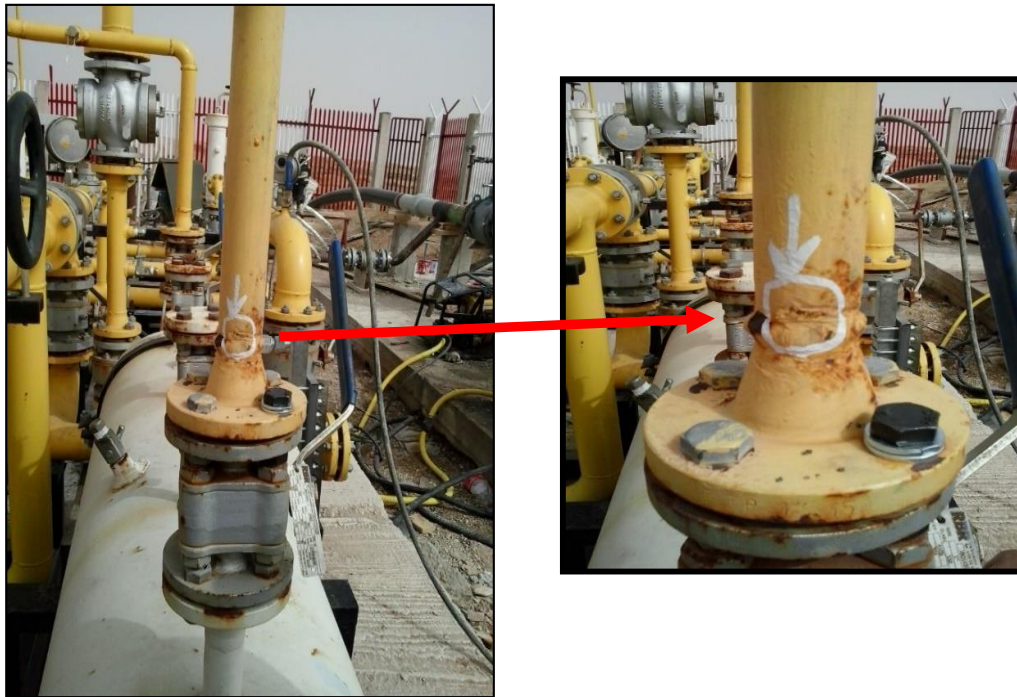
Figure 6 :Photo d'une fissure dans un joint de soudure a 32 bar.
