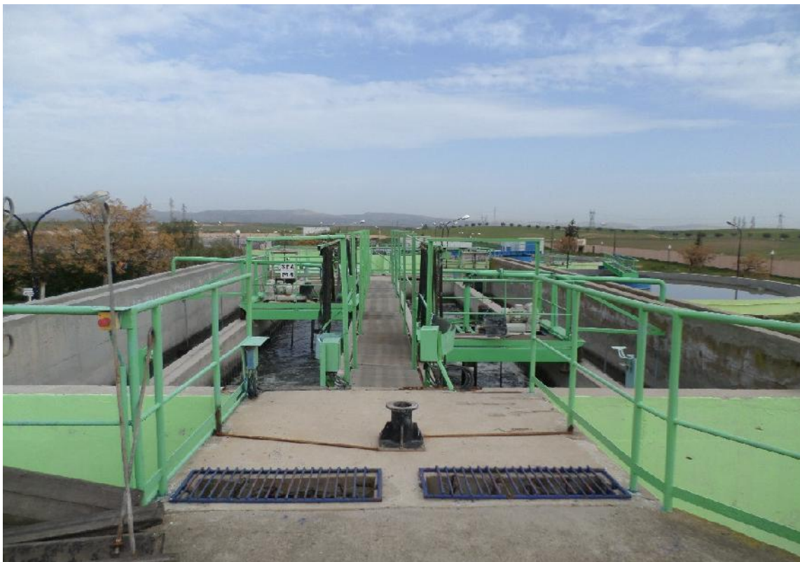
Figure N 13 : schéma du dessableur déshuileur (ONA DE SBA, 2021).
