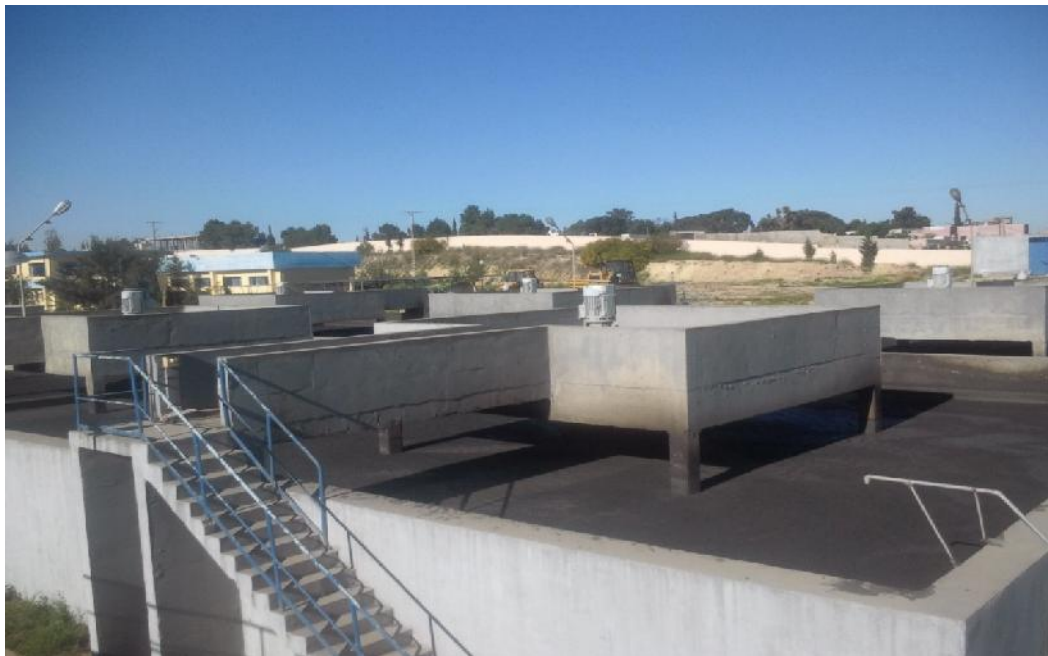
Figure N 18 : Bassin de stabilisation (ONA, 2021)
