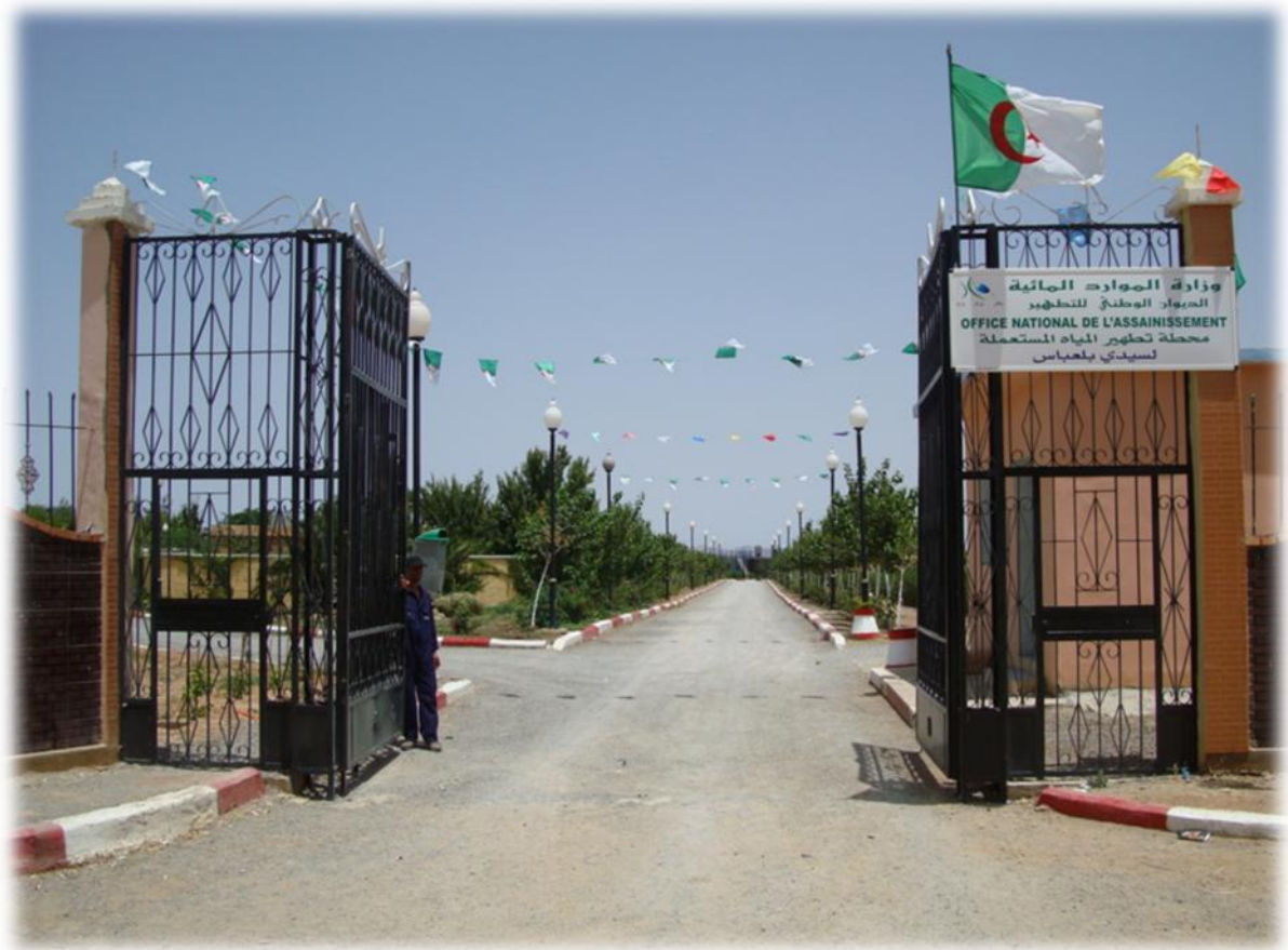
Figure N 09 : Entrée de la station d'épuration (ONA de SBA, 2021).
