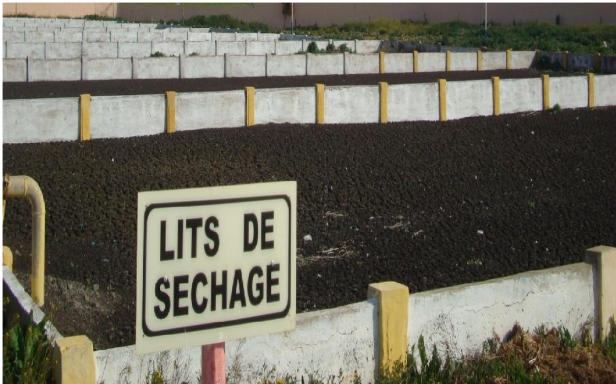
Figure N 20 : déshydratation naturelle des boues (24 lits de séchage) ( ONA, 2021 )
