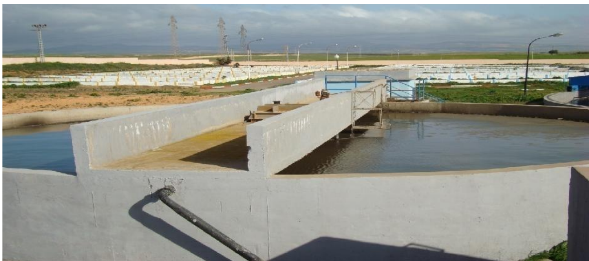
Figure 19 : Epaississement des Boues (ONA, 2021).
